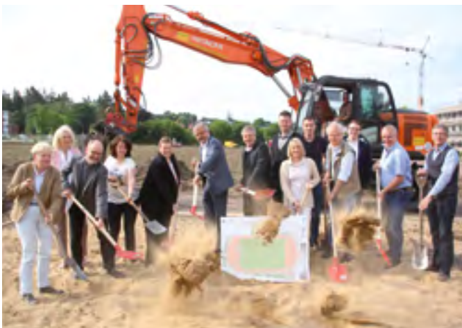
Mai: Spatenstich zur Sanierung des Sportplatzes.
