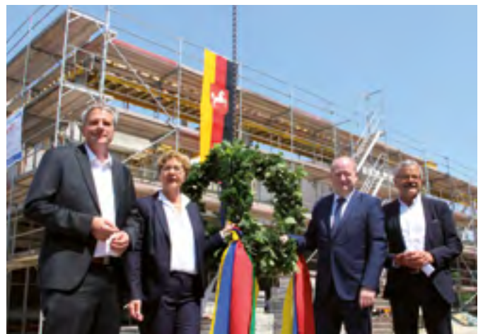
Mai: Richtfest zur Sanierung der Mensa.
