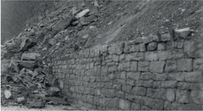
Felsrutschung vom 10.2.1937 an der ehemaligen Reichsstraße bei Hann. Münden (Oberweser). Die Trockenmauer stützt den Böschungsfuß, ist gegen vom Hang abrutschendes Gestein jedoch wirkungslos. (Quelle: St.A. Münden B-1937-2)
