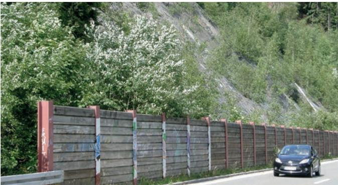
Prallwand zur Sicherung der Bundesstraße 498 im Oberharz. Die Vorrichtung ist als Palisadenwand in Stahl-Holz-Konstruktion zum Schutz gegen Steinschlag konstruiert und wirkt gegen kleinere abspringende Steine und Blöcke. (Bild: Damm, 2011)
